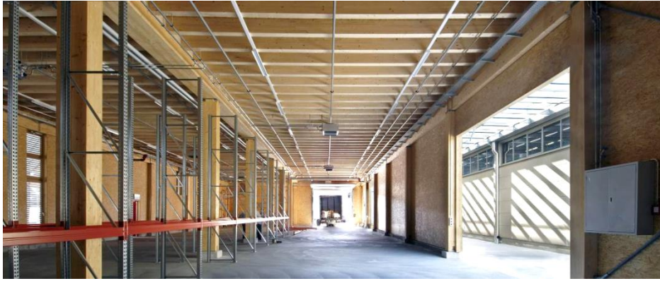
Structures porteuses, dalles mixtes bois-béton et façades pour bâtiments scolaires, logements et immeubles administratifs.
